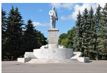
16. ремонт памятника В.И. Ленину
