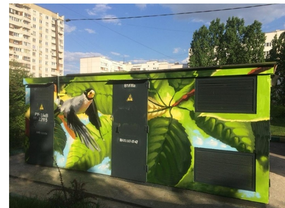
4. оформление трансформаторной подстанции граффити
