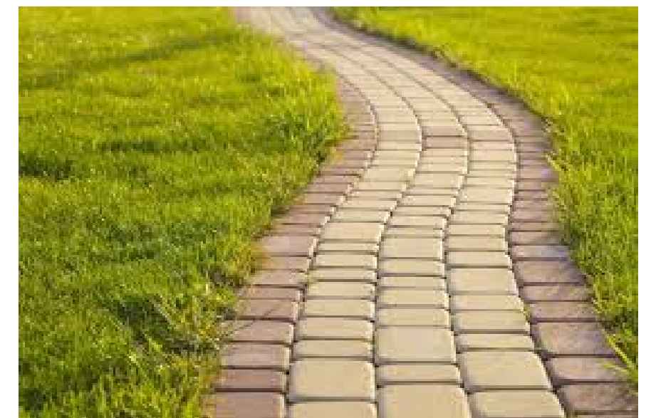
3. устройство парковой дорожки из фигурной "брусчатки"
