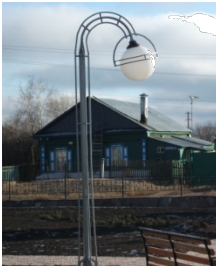
7. установка парковых фонарей
