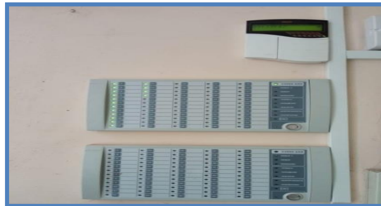
Установка и ремонт АПС в школах №2,5,7
