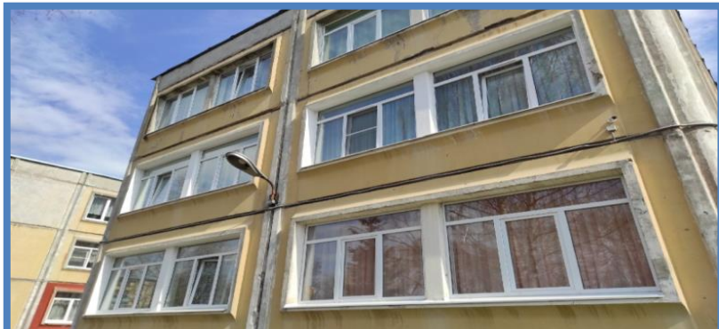
Замена оконных блоков в детском саду №5
